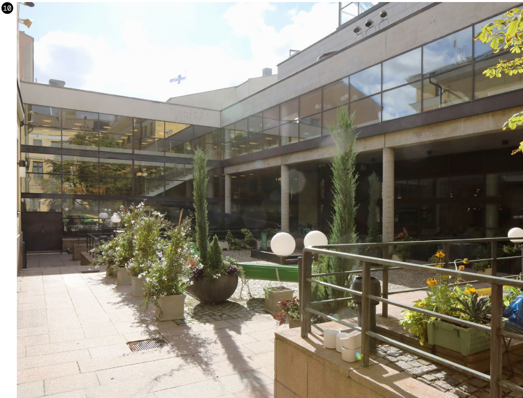
← Itäisellä sisäpihalla kaupungintalon julkisivut ovat pääosin puhtaaksi valettua betonia ja lasia messinkiprofiilein.
