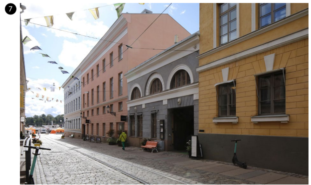
↑ Matalan osan kohdalla oli talonmiehen asunto, jonka julkisivu oli 1970-luvulla kirkkaan turkoosi.
