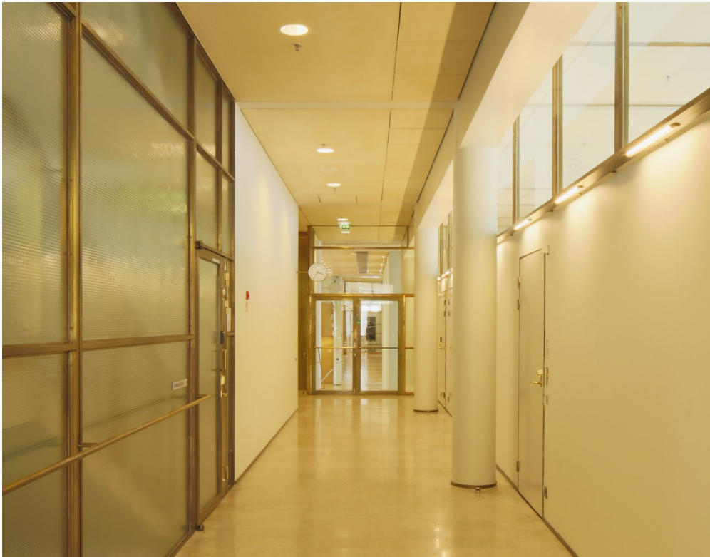
↑ Ensimmäisen kerroksen läntinen sivukäytävä kuvattuna länsipäästä. Käytävää reunustaa julkisivun puolella pilaririvi ja korkea palkki. Vasemmalla on porrashuoneen lasiseinä.
