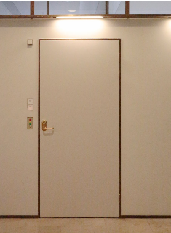
← Toimistotilojen tyyppiövi on yksinkertainen valkoiseksi maalattu laakaovi. Ovenkarmit ovat messinkiset ja upotettu samaan tasoon rappauspinnan kanssa. Ovien vierellä on säilynyt muun muassa alkupe räisiä ovisummerin painikkeita ja kuution muotoisia merkkivaloja.
