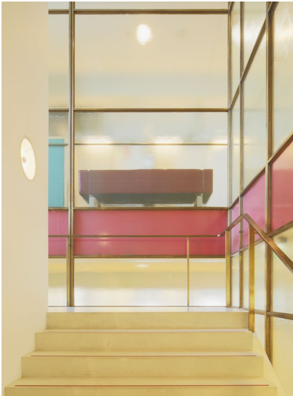
↑ Porraskuilu on messinkiprofilein jäsenneltä rautalankalasia. Porrasaskelmat ovat pienirakeista, harmaanvalkoista mosaiikkibetonia.
