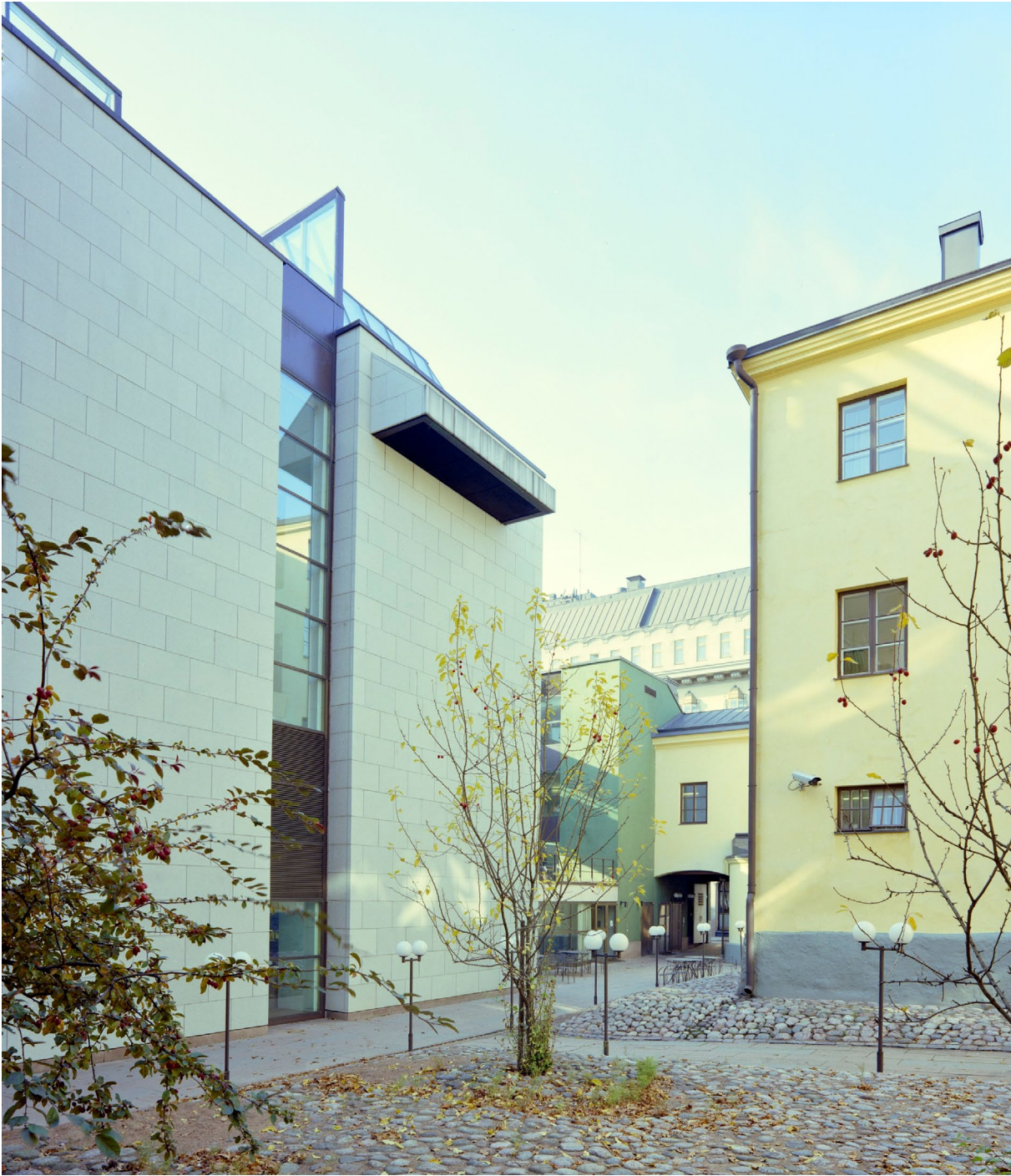
↑ 1988 valmistunut kuutiomainen valtuustosali valokuvattuna ennen uusimpia pihamuutoksia. HKM.
