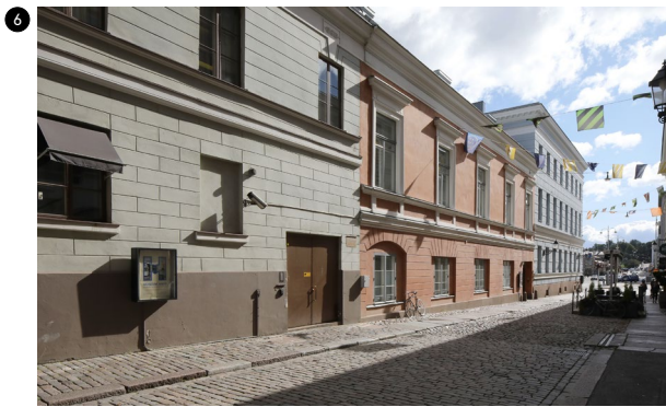
↑ Sofiankatu etelään. Punertavan rakennusosan kohdalla toisessa kerroksessa on entisen kokoushuoneen ikkunat.
